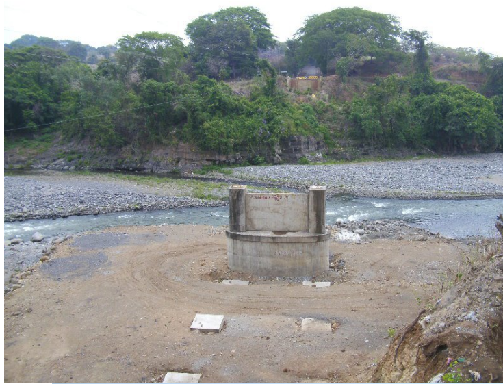
Los Escalvos die "gestohlene" Brücke
